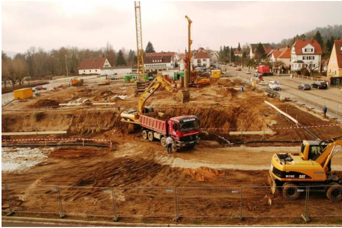
Baugrube des Neubaus an gleicher Stelle im Februar 2008
