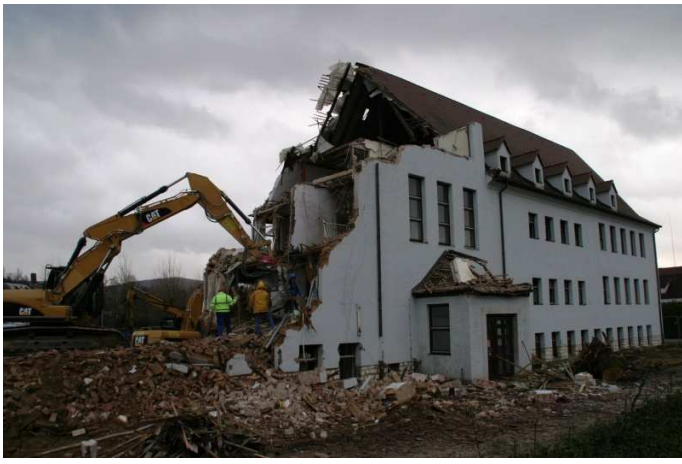
Abbruch des alten Finanzamtsgebäudes im November 2007
